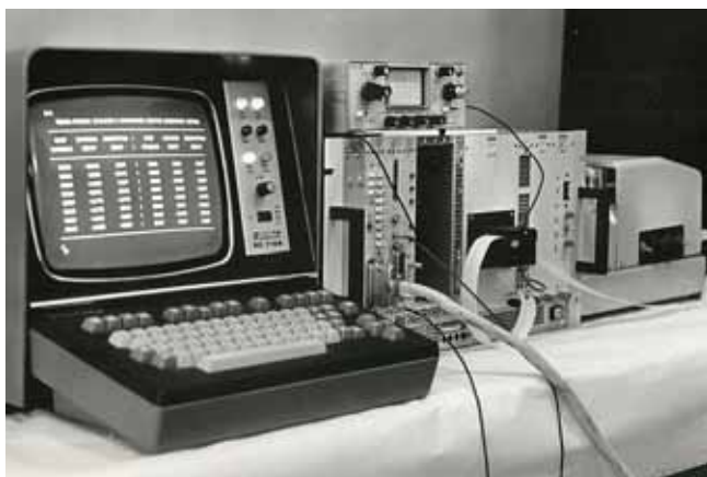
Рис. 1. Мобильная система для автоматизации экспериментов по исследованию спектрального состава радиосигналов (1981 г.)
